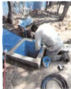
Foto 3: el citerna no esta impermeabilizado y causa daño en la pared de una clase afectada con humeda
