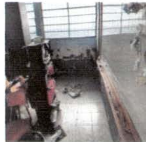
Foto 2: 2do, C, cesta pared sera repellada por causa se humedad. Posteriormente se pintara
