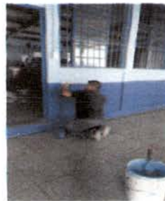
Foto 6: cambio de pintura en varias paredes por humedad
