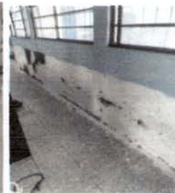
Foto 2: 2do, C, cesta pared sera repellada por causa se humedad. Posteriormente se pintara
