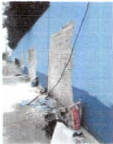
Foto 1: pared exterior esta en muy mal estado, se cae el repello, tiene humedad en gran parte de ella.
