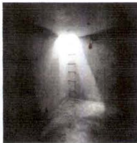
Foto 3: el citerna no esta impermeabilizado y causa daño en la pared de una clase afectada con humeda
