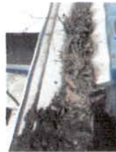
canales sucios, llenos de tierra y maleza que impidiran paso de agua
