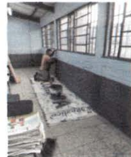
Foto 6: cambio de pintura en varias paredes por humedad
