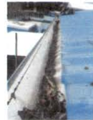
canales sucios, llenos de tierra y maleza que impidiran paso de agua
